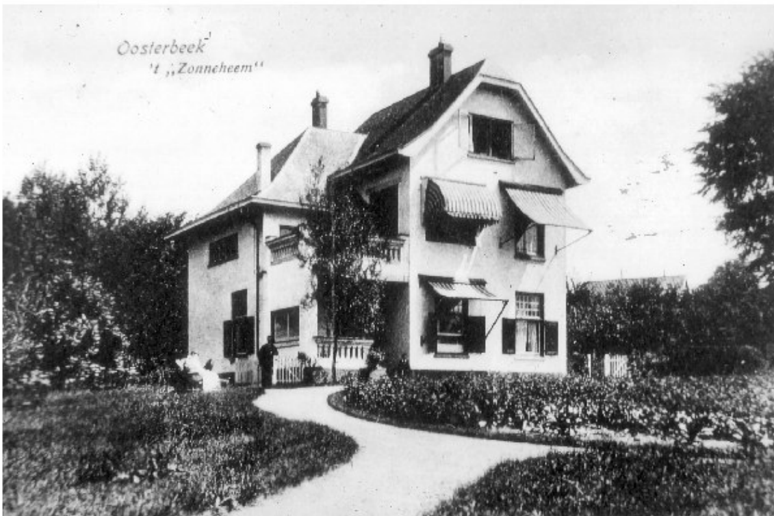
Afbeelding: Foto van 't Zonneheem (ca. 1918), uit de periode dat de familie Bothenius Brouwer in het huis woonde. De open ruimte van de loggia op de bovenetage is goed te zien.
