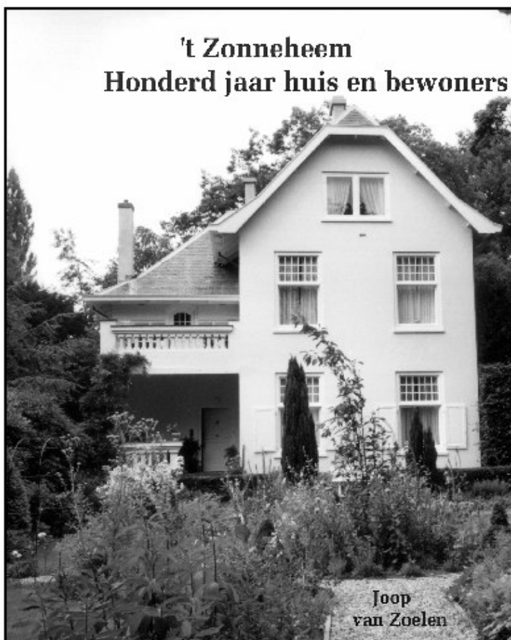
Afbeelding: Boek uitgegeven ter gelegenheid van het honderdjarige bestaan van 't Zonneheem (juni 2007).
